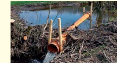
ein Niveau abgesenkt werden, bei dem die Felder wieder bearbeitet werden können. Die Baumaßnahme wird unter Aufsicht des Biberbeauftragten so ausgeführt, dass auch der Biber weiter hier leben kann.
