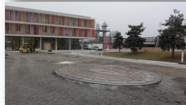
Bild: Kunst am Bau, überdimensionaler Hydrantendeckel vor Gebäude 2 (LFS)
